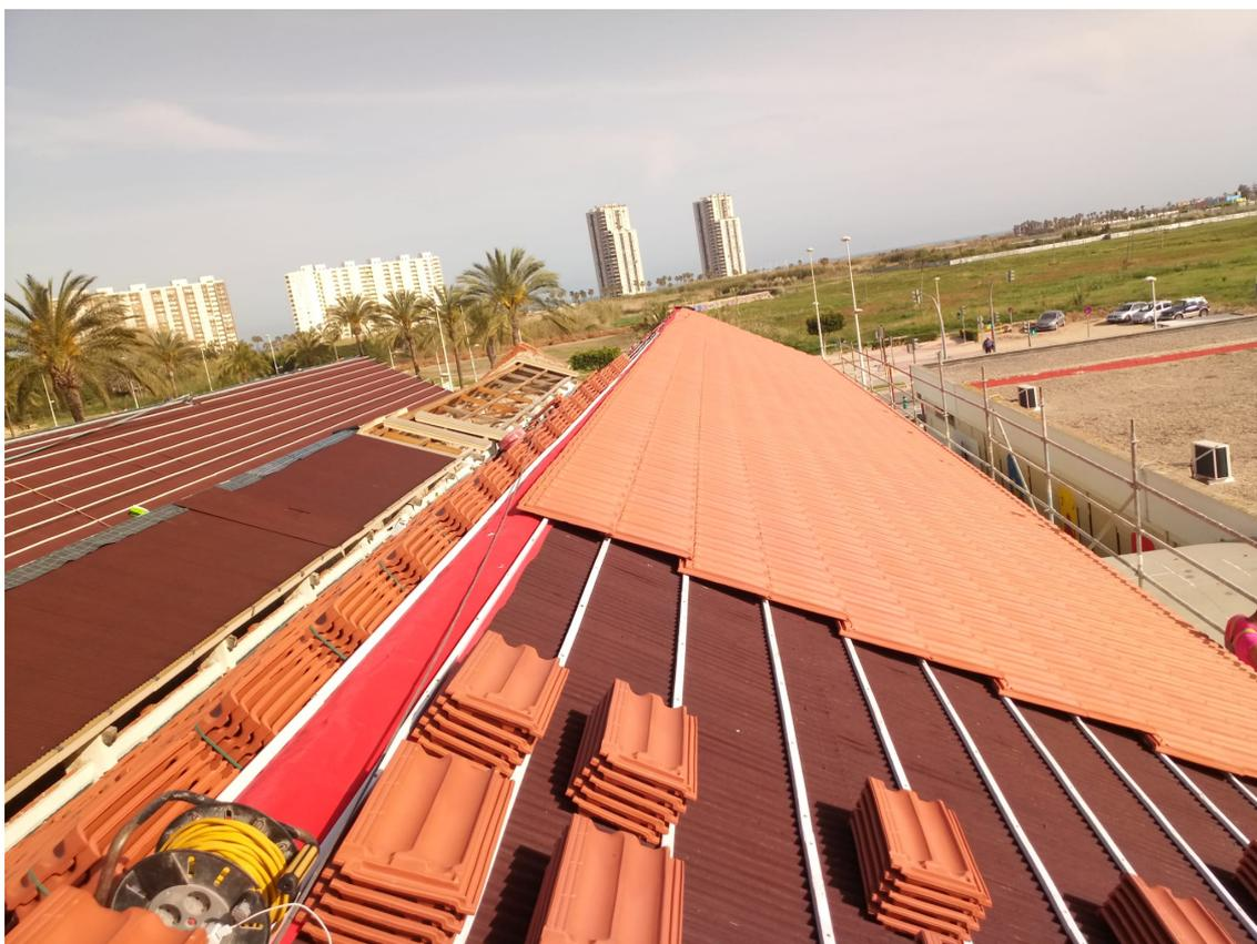
Con este sistema se garantiza la impermeabilización del tejado, aunque se desplacen o rompan las tejas, por lo que resultan una **protección excelente para el aislamiento térmico de la cubierta**, manteniendo sus prestaciones en condiciones óptimas durante muchos años. Una vez instalada la impermeabilización del tejado, se procede a la ejecución y presentación de los distintos remates de cubierta como la cumbre, el alero y canalón.
