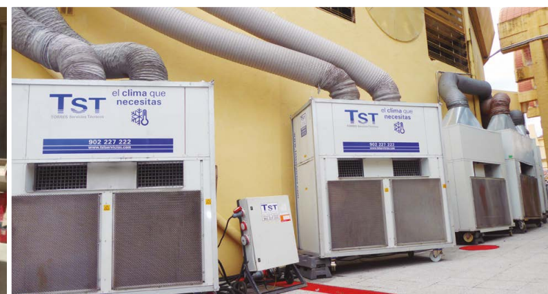
Equipos autónomos de aire con bomba de calor desde 10 KW a 36 KW
