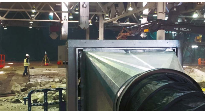
Pantallas y Cajas de ventilación insonorizadas para grandes volúmenes de 20.000 a 250.000 m3/h
