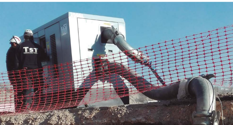
Bombas para aguas muy cargadas de 1,5 a 11 KW
